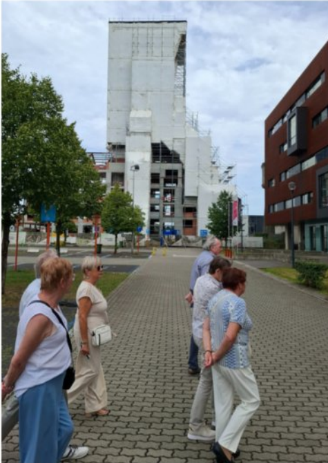
De schachttoren die een grondige renovatie krijgt
